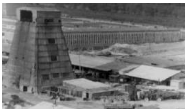
Rozpoczęcie budowy Huty Miedzi w Głogowie
